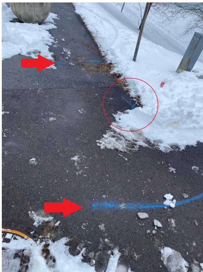
Figur 4. Platsen där läckan misstänks befinna sig. Pilarna visar läcksökningshundens markeringar och cirkeln visar driftteknikers markering.
